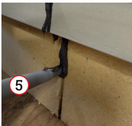
5. Spalt mit Dichtkleber* 1 versiegeln
