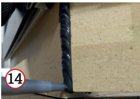
14. Spalt mit Dichtkleber*1 versiegeln
