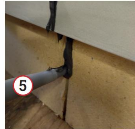
5. Spalt mit Dichtkleber*1 versiegeln
