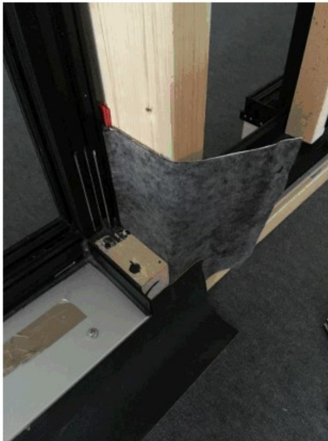
Detail ONE S Schema A anschlagseitig unten mit Anschlussflansch
