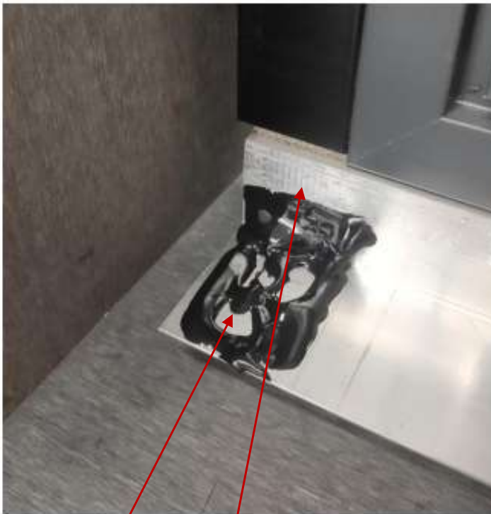
All Season im unteren und hinteren Bereich auftragen.
