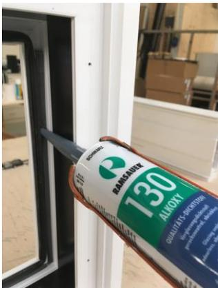
6. Die Ecke vom senkrechten zum waagrechten Rahmen wird zusätzlich mit 640 Kleber abgedichtet
