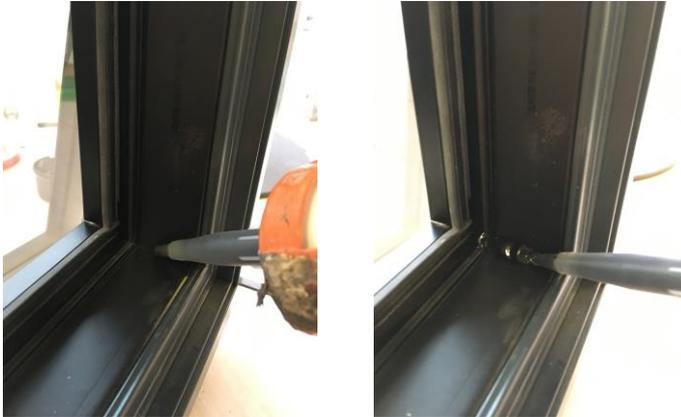
7. Die mitgelieferten grünen Glasklötze für die Verglasung einlegen und nochmals mit 640 Kleber über die Glasklötze spritzen. Der Abstand der Klötze soll eine Klotzlänge betragen. Keinesfalls den Klotz ganz ins Eck schieben – **Glasbruchgefahr!**
