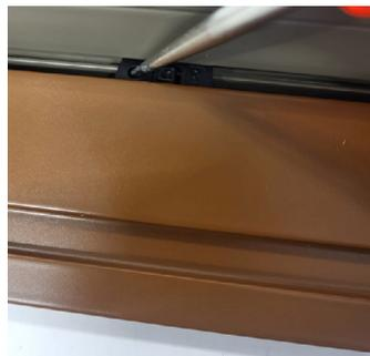
5. Einstellen der Offenposition des ISG Flügels, zB. zur Vorderkante des geöffneten Schiebeflügels
