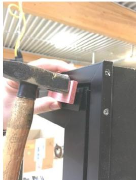
3. Den ISG Spannrahmen in die ISG Halter 05 einhängen. Mit Hilfe der beidseitigen Positionierwinkel am ISG Spannrahmen wird dieser richtig in der Lichte positioniert.
