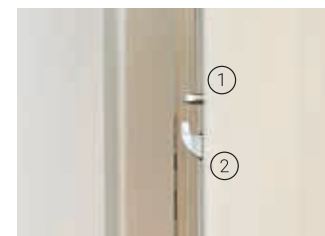
Rundbolzen ① Schwenkriegel ②
