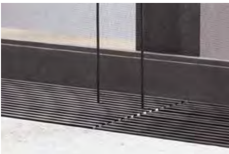
bei Entwässerungsschacht mit Designrost
