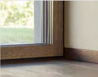
Sockelleiste mit flächenbündigem Wandabschluss
