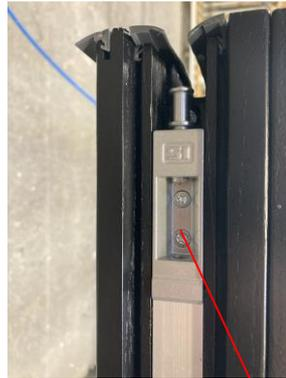
Verriegelung Flügel entfernen
