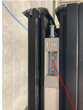
Verriegelung Flügel entfernen
