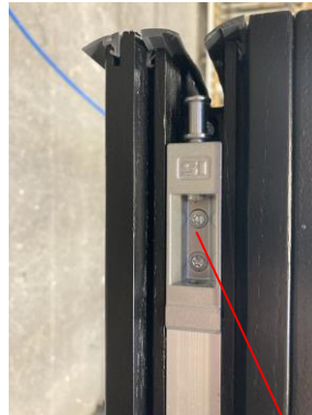
Verriegelung Flügel entfernen
