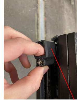
Führungsgleiter entfernen
