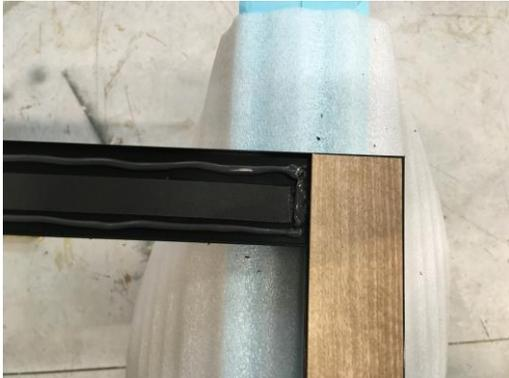
8. Nach dem Einbringen der senkrechten Applikationen, 640 Dichtkleber links, rechts und stirnseitig neben dem Klebeband der waagrechten Applikationen auftragen. Die Kleberaupe muss mindestens so hoch sein, wie das Klebeband.
