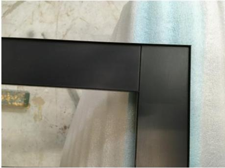
11. Wenn die Stoßdichtung über die Applikationen steht, muss diese mit einem scharfen Messer sorgfältig bündig geschnitten werden.
