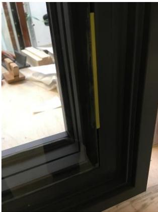
9. Den Zwischenraum zwischen Glas und Rahmen punktuell alle 30cm mit 640 Kleber bis zur mittleren Glasscheibe ausfüllen.
