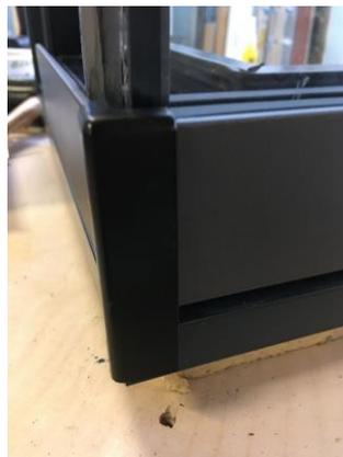
19. Die zu versiegelnde Glasfuge beim Alurahmen zuerst reinigen und entfetten (Silikonhaftung!), dann außen mit dem mitgelieferten **schwarzen** Silikon versiegeln.
