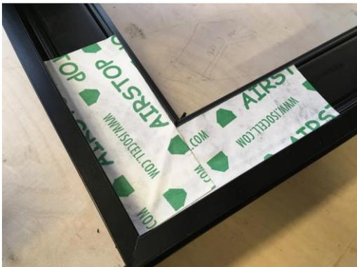
5. Am Grund des Profils wird umlaufend eine Raupe Silikon aufgebracht. Dies dient für die Luftdichtheit des Elements.
