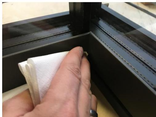
18. Die Rückseite der Alu-Eckkappen mit elastischen Montagekleber oder Silikon bestreichen und mit Kleband auf Zug über die Alu Rahmenecke kleben.
