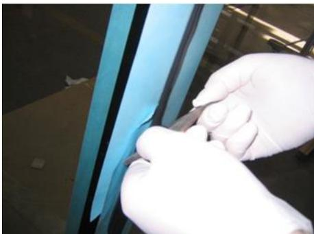
16. Dann mit Wasser benetzen die Spachtel leicht durchbiegen und in einem Zuge die Fuge von unten nach oben leicht nach innen gewölbt abziehen. Klebeband wieder entfernen.
