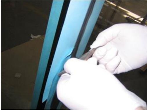
16. Dann mit Wasser benetzen die Spachtel leicht durchbiegen und in einem Zuge die Fuge von unten nach oben leicht nach innen gewölbt abziehen. Kleband wieder entfernen.
