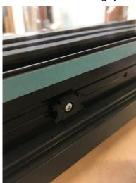
8. Den Rahmen des Abdeckprofils auf die Klipse aufklipsen, **ACHTUNG:** seitlich und oben ist beim Abdeckprofil eine Silikondichtung aufgebracht. Unten darf diese nicht vorhanden sein, da ansonsten die Systementwässerung nicht mehr funktioniert.
