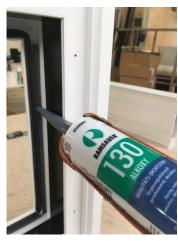
3. Die mitgelieferten Glasklötze für die Verglasung einlegen und nochmals mit 640 Kleber über die Glasklötze spritzen. Der Abstand der Klötze soll eine Klotzlänge betragen. Keinesfalls den Klotz ganz ins Eck schieben – **Glasbruchgefahr!**Bei Glasbreite >2m soll der Abstand der Klötze von den Glasscheibenecken etwa 2 Klotzlängen betragen.
