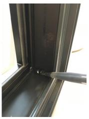
2. Am Grund des Profils wird umlaufend eine Raupe Silikon aufgebracht. Dies dient für die Luftdichtheit des Elements.
