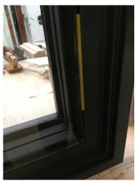
5. Den Zwischenraum zwischen Glas und Rahmen punktuell alle 30cm mit 640 Kleber bis zur mittleren Glasscheibe ausfüllen.
