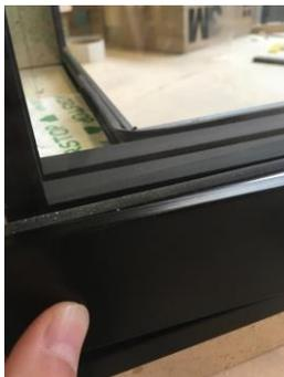
7. Die witterungsseitige zu versiegelnde Glasfuge beim Stock zuerst reinigen und entfetten (Silikonhaftung!), dann mit dem mitgelieferten **schwarzen** Silikon versiegeln.
