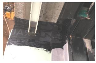
6. Der Übergang vom Grundprofil auf den Dämmkeil ist ebenfalls mit Folienbänder abzudichten. Es empfiehlt sich die seitliche Leibung (zumindest im unteren Bereich) mit einem Dämmmaterial, welches kein Wasser aufnehmen kann (z.B. XPS), zu dämmen.
