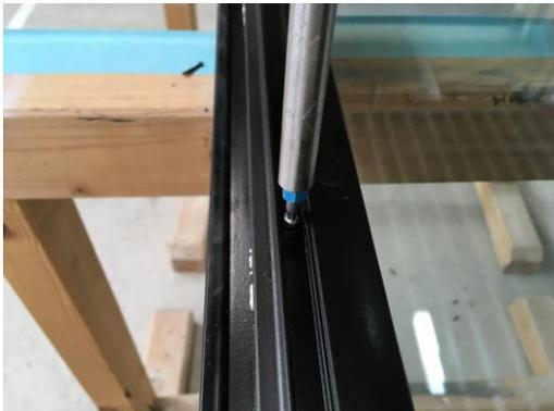
4. Die Glaskantenabdeckprofile sind mittels Klebedichtung mit dem Glas verklebt, diese mit einem Glasheber vorsichtig vom Glas lösen.
