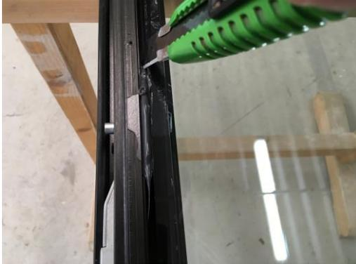
6. Den Flügel mit der Außenseite nach unten drehen. Die Innenseite des Flügels ist nassverglast. Das Silikon und das Klebeband (früheren Lieferungen) bzw. die innere Klebedichtung mit einem scharfen Messer abschneiden.
