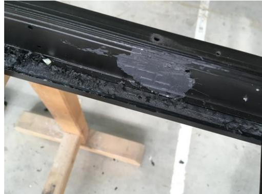
9. Wurden beim Entfernen der Glaskantenabdeckprofile die Eckkappen beschädigt, müssen diese ersetzt werden. Eckkappen werden grundsätzlich mit dem Montageset mitgeliefert. Hierbei werden bei den waagrechten Profilen die Eckkappen mit Sekundenkleber angeklebt.
