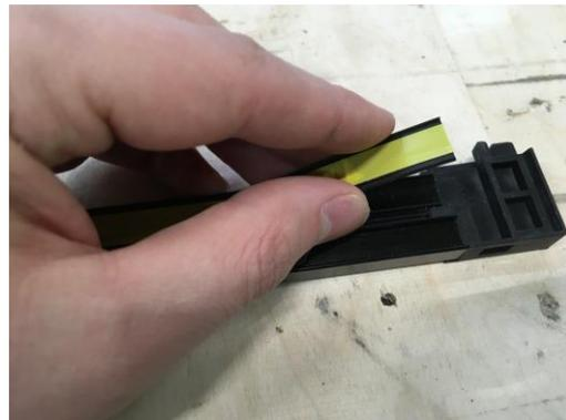
11. Beim Flügel ebenfalls mit Haftgrund vorbehandeln und die Klebedichtung aufkleben. Die Klebedichtung wird an den Enden stumpf verklebt
