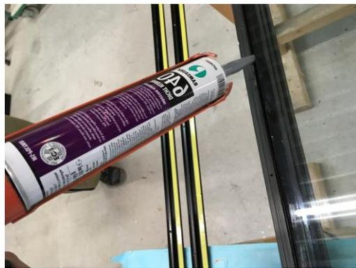
16. Die Glaskantenabdeckprofile inkl. der Klebedichtung unten waagrecht beginnend montieren und mit den 3,5x22mm Schrauben anschrauben. Nach dem das untere Abdeckprofil montiert wurde, sollten die beiden senkrechten Profile montiert werden. Die Profile in die Eckkappen einbringen, erst dann das waagrechte obere Glaskantenabdeckprofil einstecken und verschrauben.
