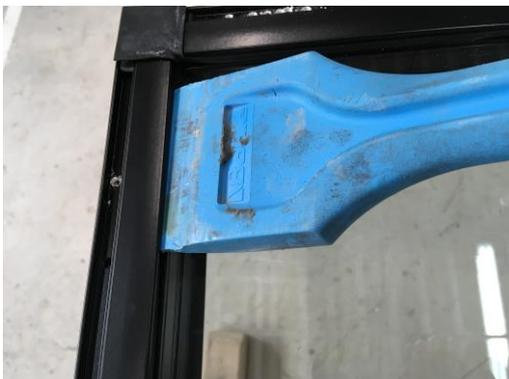
5. Das Glas wurde punktuell, ca. alle 30cm, mit 640 Dichtkleber bis zur mittleren Scheibe ausgespritzt. Den Dichtkleber mit einem scharfen Messer herausschneiden.
