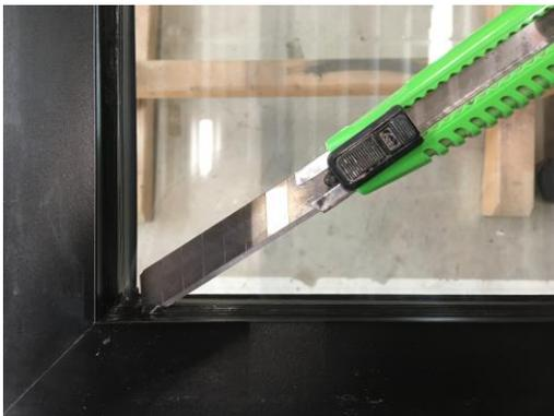
7. Wurde die Silikonfuge abgeschnitten kann das Glas durch wegheben des Flügels entfernt werden.
