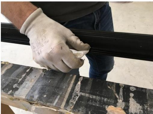
12. Die Folie von der Klebedichtung entfernen, Glasrand reinigen und das Glas einsetzen. Glas lt. Richtlinie ausklotzen
