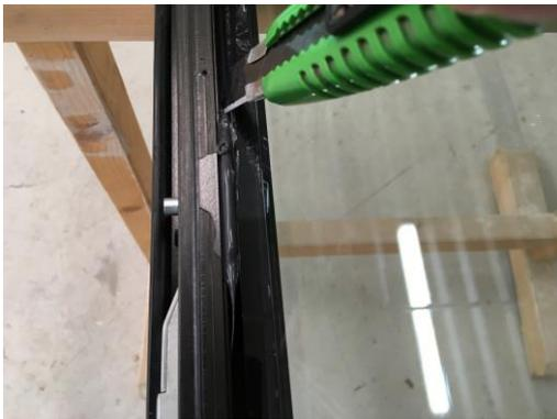
4. Den Flügel auf die Außenseite drehen. Die Innenseite des Flügels ist nassverglast. Das Silikon und die innere Klebedichtung mit einem scharfen Messer abschneiden.
