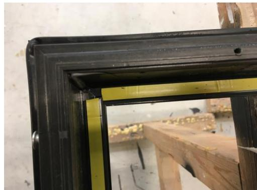
9. Die Klipse am Flügel entfernen und neue Klipse aus dem Montageset anschrauben. Beim Entfernen des Verglasungsrahmens werden die Klipse beschädigt und dürfen in weiterer Folge **nicht** mehr verwendet werden.
