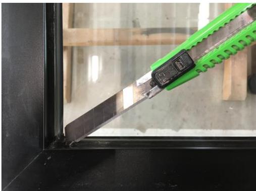
5. Wurde die Silikonfuge abgeschnitten kann das Glas durch wegheben des Flügels entfernt werden.
