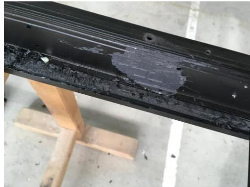
7. Beim Verglasungsrahmen die mitgelieferte Klebedichtung aufbringen. Die Dichtung wird stumpf gestoßen.
