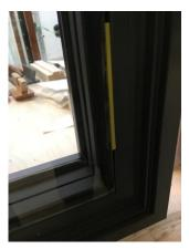
15. Den Zwischenraum zwischen Glas und Rahmen punktuell alle 30cm mit 640 Kleber bis zur mittleren Glasscheibe ausfüllen.
