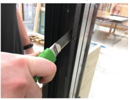
9. Glas wegheben und Element von Kleberrückständen befreien. Die abgeschnittene Glasdichtung aus der Nut entfernen und die neue Dichtung einziehen.
