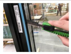
5. Dann können die Verglasungsleisten (4 Einzelteile) entfernt werden.
