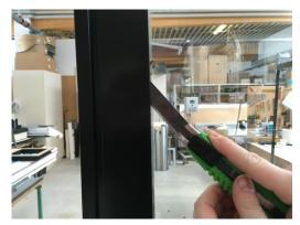
7. Der Fixteil Blue ist am Glasfalzgrund mit Silikon verklebt, um die Luftdichtheit des Elements sicherzustellen, dieses muss mit einem Messer abgeschnitten werden.
