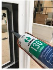
13. Die mitgelieferten Glasklötze unten in den Rahmen einlegen und mit Silikon die Abdichtung im Bereich der Klötze ergänzen. Der Abstand der Klötze von der Rahmenecke soll ca. 10 cm betragen. Keinesfalls ganz in der Ecke platzieren – **Glasbruchgefahr!**
