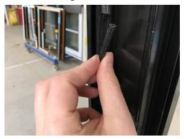
10. Die Glashalteleisten reinigen - Klebeband und Silikonrückstände entfernen und mit Korrekturanlöser reinigen.
