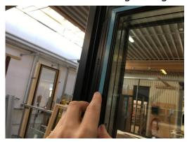
6. Die Verglasungsdichtung auf der Innenseite des Elements mit einem Messer herausschneiden
