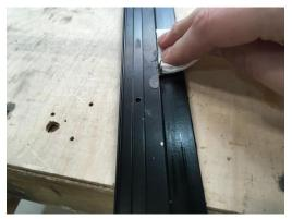
11. Das Klebeband (2,0x9mm) für die Verklebung zum Glas auf die Glashalteleisten wieder aufbringen
