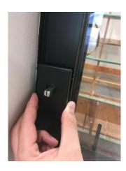
3. Den Griff aufstecken und mit dem Inbusschlüssel gefühlvoll anziehen
