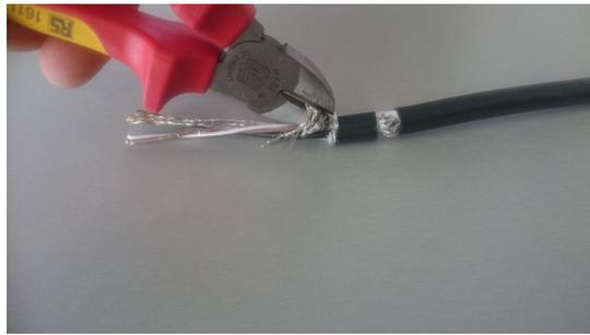
4. Schritt: Inneren Mantel des Kabels entfernen, Leitungen 7 mm abisolieren, Aderendhülsen auf die Kabel crimpen, in die Steckerklemmen drücken und festschrauben,
