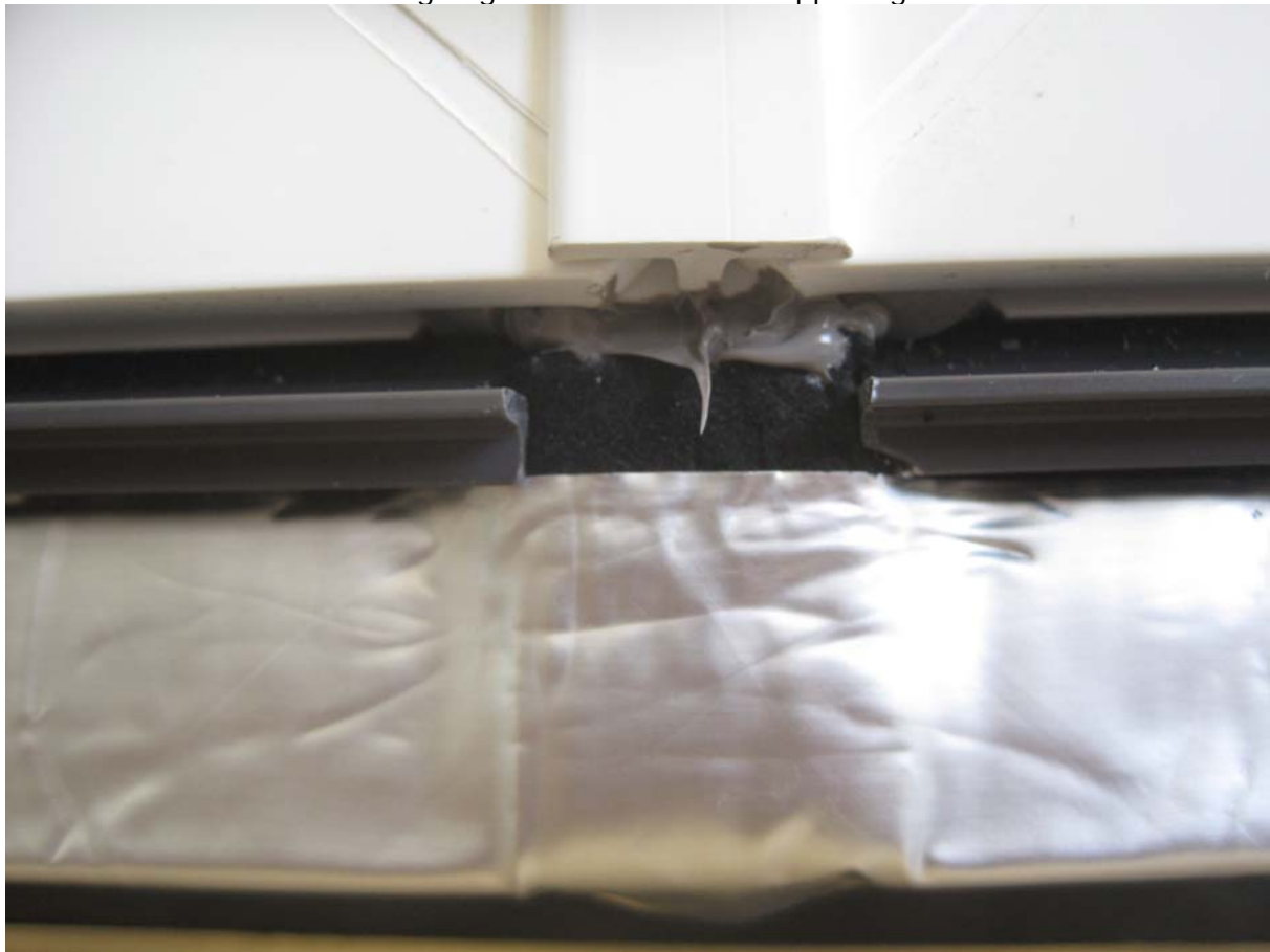
Detail fertig abgedichteter Elementkoppelungsbereich
