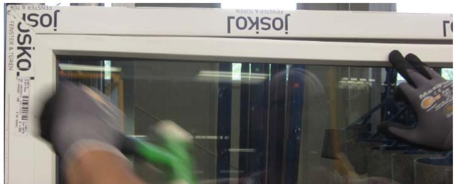
Anschließend werden die Glasleisten von der Mitte beginnend zu den Ecken eingeschlagen.
