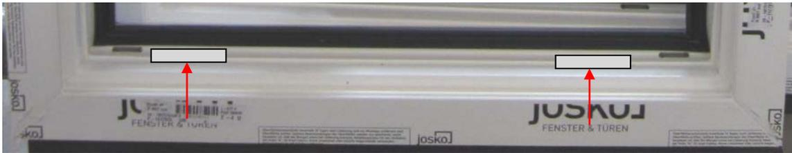
Die unteren Glasklötze (weiß) werden mit dem mitgelieferten Klebesilikon gegen das Verrutschen gesichert. Die Positionierung erfolgt links und rechts mit ca. 10 cm Abstand vom Eck. Wird der Abstand von ca. 100 cm überschritten, so werden auch im mittleren Bereich Glasklötze ergänzt.
