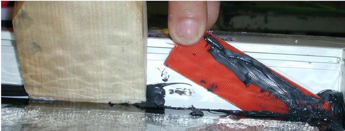
Die außenseitige Glasverklebung wird mit einer Fein- Supercutssäge zwischen der Verglasungs- dichtung und der Glasscheibe durchgeschnitten
