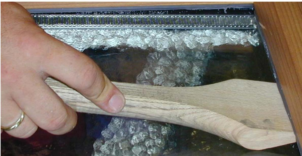
**Entfernen der Flügelglasdichtung außenseitig, nur bei Beschädigung.**
