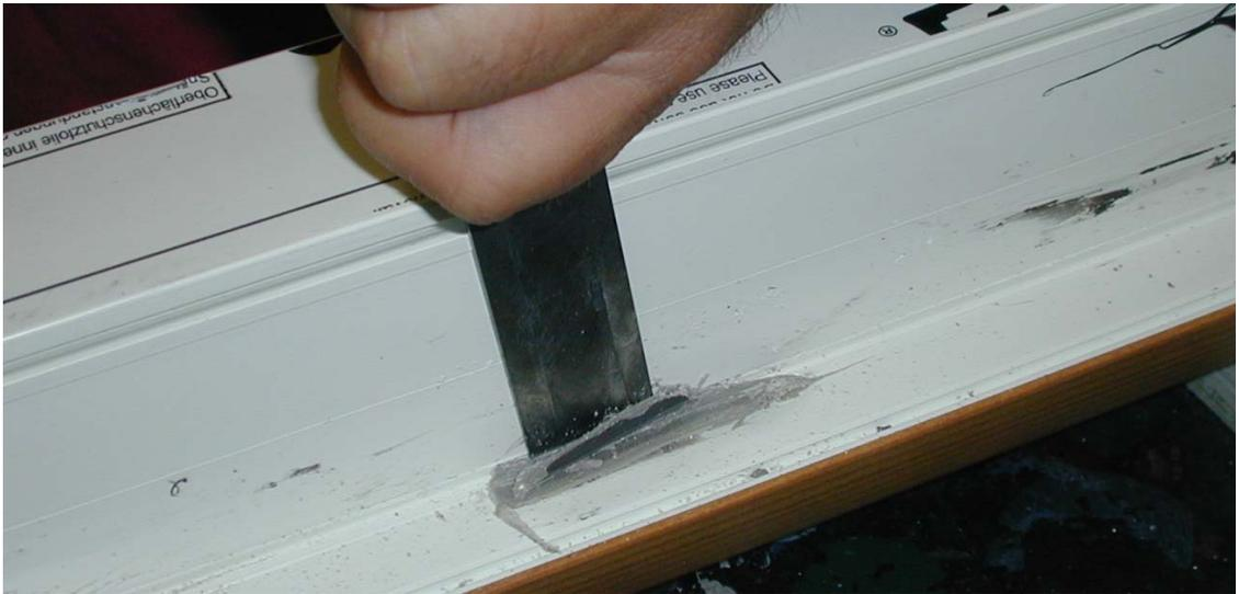
**Die neue Glasdichtung wird eingezogen und anschließend der 1-komponenten Kleber OTTO Novasil S10SP 3528 an den vorherigen Stellen aufgetragen.**
