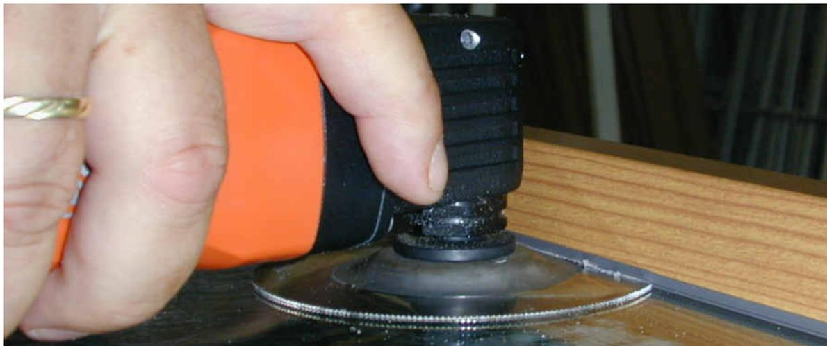
Anschließend wird die Glasscheibe aus dem Flügel gehoben.
