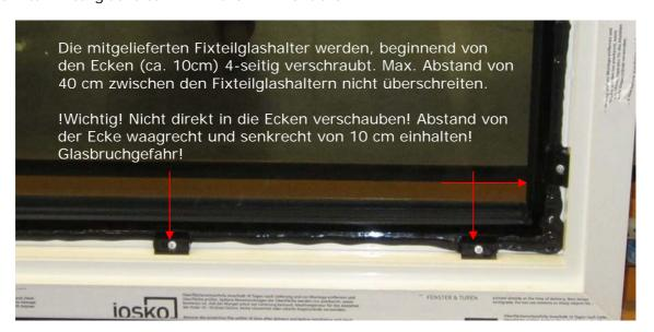
ACHTUNG: Bei der Montage der Fixteilglashalter ist die Scheibe mit dem Körpergewicht nach außen zu drücken, die Fixteilglashalter in einem ersten Schritt nur leicht anziehen. In einem zweiten Schritt mit Gefühl festziehen. Zu fest angezogene Fixteilglashalter können zum Scheibenbruch führen!
