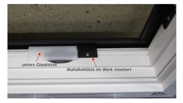
Die unteren Glasklötze werden mit dem mitgelieferten Klebesilikon gegen das Verrutschen gesichert. Die Positionierung erfolgt links und rechts direkt neben dem Aluhalteklotz. Wird der Abstand von ca. 100 cm überschritten, so werden auch im mittleren Bereich Glasklötze ergänzt.
