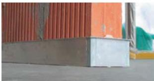
Das Profil wird vor den Putz- bzw. Trockenbauarbeiten montiert.
