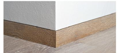
Die einzusetzende, flächenbündige Bodenleiste wird aus der Zuschnitt-diele in der Höhe angepasst und mit Montagekleber eingeklebt.
