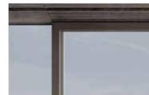
4. Rahmenloser Fixteil, schlanker Hebeschiebeflügel in Holz/Alu
