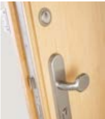
Außenzylinder und Außenrosette bei Kastenriegelschloss
