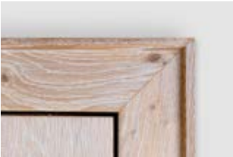
abgeschrägt – bündige Umfassungszarge BET mit abgeschrägter Zargenleiste
