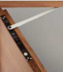
Türschließer im Falz integriert
