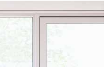
5. Sehr schlanker Fixteil, schlanker Hebeschiebeflügel in Kunststoff/Alu.
