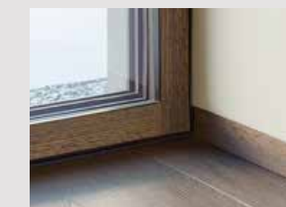
Sockelleiste mit flächenbündigem Wandabschluss
