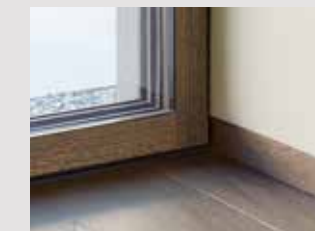
Soklová lišta se zarovnaným ukončením u stěny
