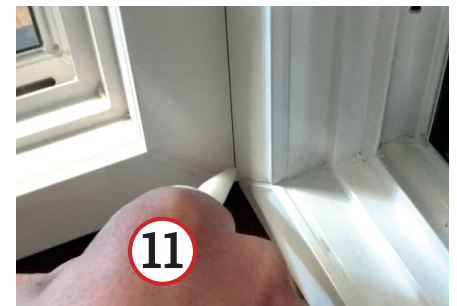
11. Spalt Innen mit PVC Kleber versiegeln
