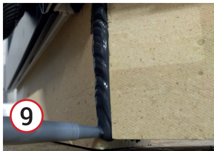
9. Spalt mit Dichtkleber*1 versiegeln
