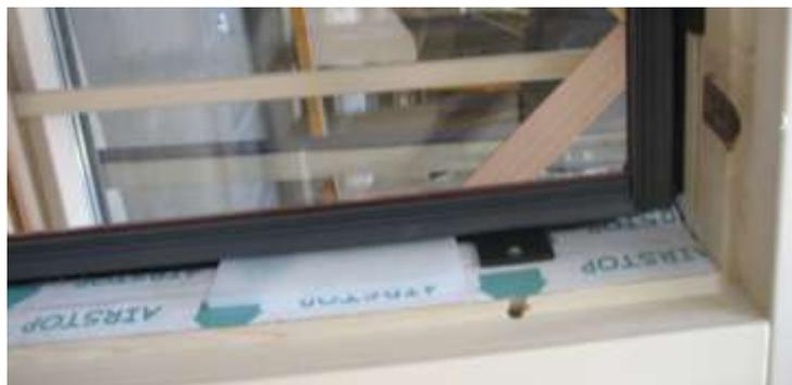
Glasscheibe auf die **Glasklötze** einsetzen und rundum auf gleiche Einbauluft ausrichten. Achtung: gegen das Herausfallen sichern!
