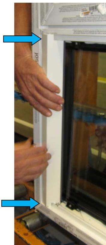
Begonnen wird mit den werksseitig kontergefrästen Glasleisten. Diese werden eingelegt und eingeschlagen.
