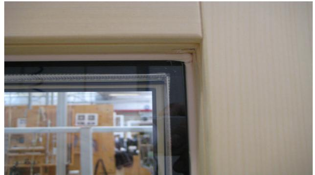
Den oberen und unteren Eckbereich vollständig mit dem im Beschlägepaket mitgelieferten Dichtstoff FASSADE 350 abdichten.
