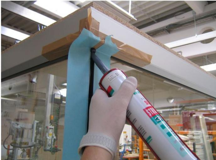
Den Glasstoß über die ganze Länge vollständig mit FASSADE 350 ausfüllen. Dabei soll die Fuge gefüllt sein und etwas Material nach außen vorquellen.
