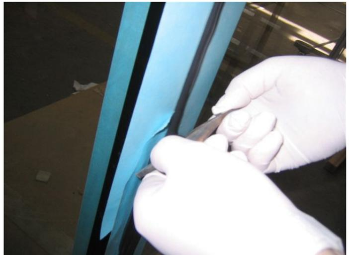
Dann mit Wasser benetzen, den Spachtel leicht durchbiegen und in einem Zug die Fuge von unten nach oben leicht nach innen gewölbt abziehen. Klebeband entfernen.
