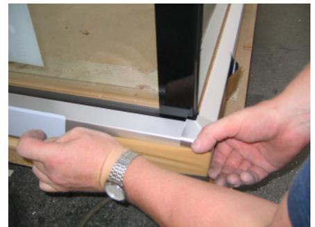
Die zu versiegelnden Alu-, Holz- und Glasfugen zuerst reinigen und entfetten (Silikonhaftung!), dann innen und außen mit Silikon (mitgeliefert im Beschlägapaket) versiegeln.
