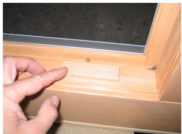
Holz und Alu-Sprossen Klebeflächen reinigen um bessere Haftung für Klebebänder und Silikon zu erreichen. Trockenzeit mind. 10 Minuten.
