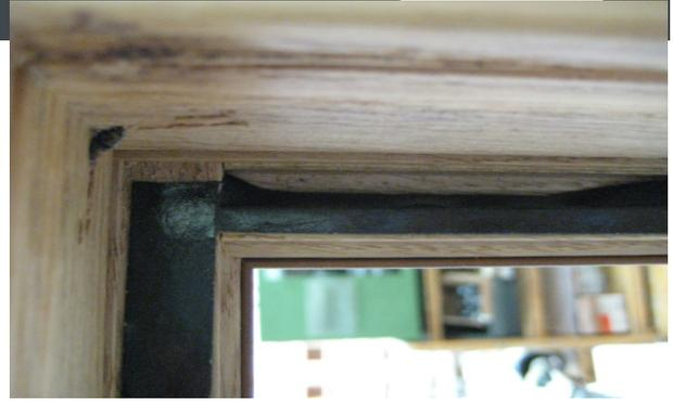
Glasecken reinigen. Glasscheibe auf die Glasklötze einsetzen und rundum auf gleiche Falzlucht ausrichten. Achtung: gegen das Herausfallen sichern!
