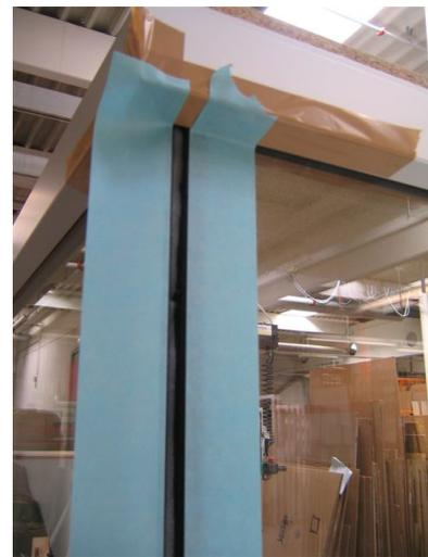
Den Glasstoß über die ganze Länge vollständig mit FASSADE 350 ausfüllen. Dabei soll die Fuge gefüllt sein und etwas Material nach außen vorquellen.
