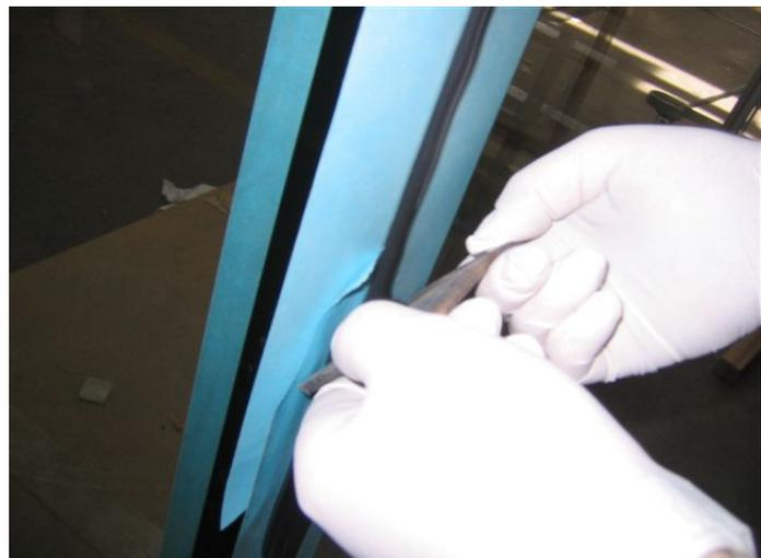
Rückseite der Alu-Eckkappen aus dem Zubehöropaket und Ecken der Alurahmen mit geeignetem Alu-Primer entfetten.
