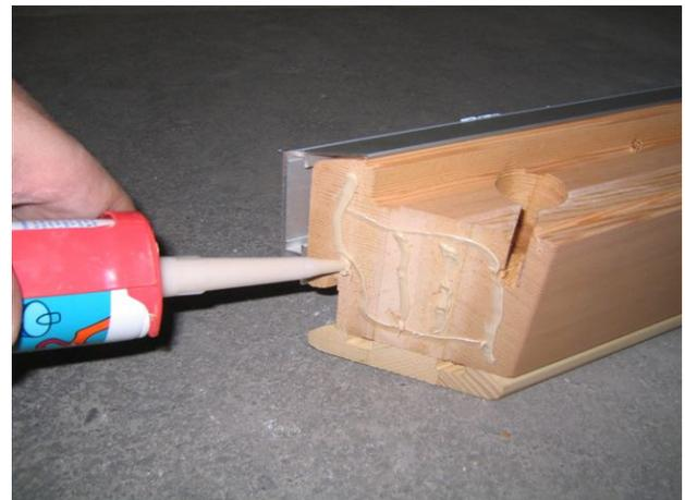
Arbeitsplattenverbinder in die 2 Öffnungen am Rahmen einsetzen und mit Gabelschlüssel 10mm fest zusammenziehen. Dabei darauf achten, dass die Rahmenteile bündig sind und gegebenenfalls ausrichten. Austretenden Kleber sofort entfernen.
