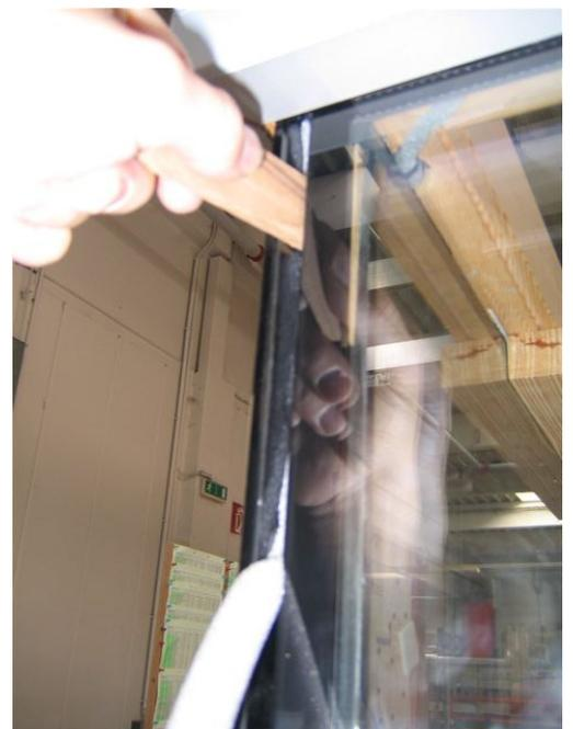
Glasleisten einklopfen bis sie an den Glashaltern „einklipsen“.
