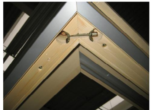
Am oberen Rahmen Arbeitsplattenverbinder in die 2 Öffnungen an der Oberseite (Bild links) und an der Unterseite (Bild rechts) einsetzen und mit Gabelschlüssel 10mm fest zusammenziehen. Dabei darauf achten, dass die Rahmenteile bündig sind und gegebenenfalls ausrichten. Austretendes Silikon sofort entfernen.
