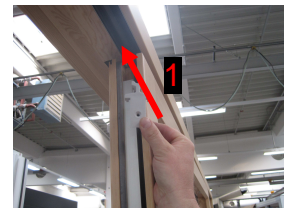
Abb. 3: Einhängen des Flügels
