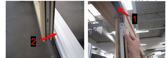
Abb. 3: Einhängen des Flügels
