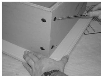
6. Nun Verkleidungsverbinder einsetzen, Falzverkleidungen eben richten und gefühlvoll verschrauben. Futterteile durch die beiden Schraubverbinder fest verschrauben.
