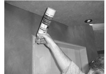
20. Nach dem Aushärten des Schaums Spreizen entfernen und eventuell überstehenden Schaum abschneiden. Bei erhöhten Anforderungen an den Schallschutz, Hohlraum zwischen den Schaumpolstern mit Mineralwolle ausstopfen.
