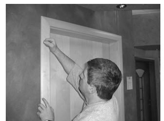
23. Bei Gesimse-Montage: Gesimse auf Verkleidung aufsetzen, mittig ausrichten und mit beigepackten Schrauben verschrauben.
