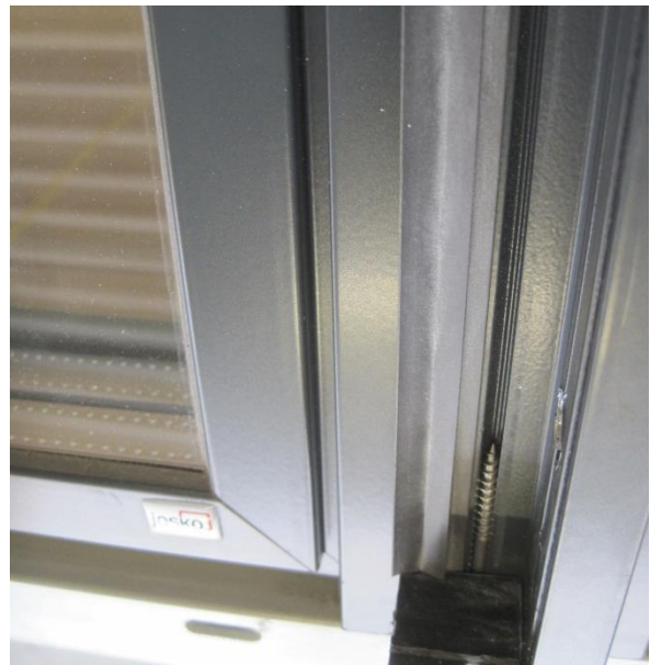
Glasdichtung 1 [17-ffdi-0007] im Profil 1 einziehen
