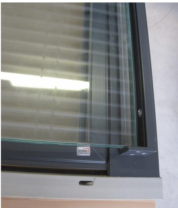
absturzsicherndes Glas einsetzen
