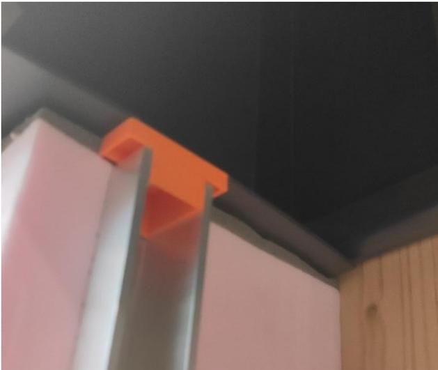
Zum Ausrichten empfehlen sich Zwingen und Montageklötze. Ist das Leibungsprofil ausgerichtet wird es mit den mitgelieferten Schrauben zweimal pro 125 cm XPS-Profil gerade in die Stockverbreiterung verschraubt. Die Schraubposition wird durch eine Positionsnut vorgegeben. Die Schraube wird im XPS versenkt.
