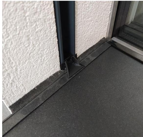
Erst jetzt werden die Einlegeschinen montiert, diese stehen auf dem Wasserspeier auf und werden mit den entsprechenden Schrauben befestigt.
