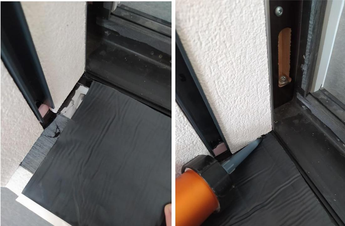
Falls möglich, sollte vor der Montage der Raffstore Einlegeschiene, die Designfensterbank inkl. seitlicher Abschlüsse montiert werden.
