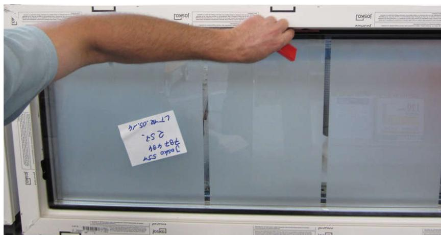
Anschließend werden die mitgelieferten Glasklötze (rot) links, rechts und oben zwischen Rahmenprofil und Glasscheibe geklemmt. Das Glas ist anschließend zentriert auszurichten.
