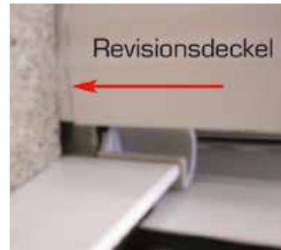
max. Putzkante bei Vorsatzrollläden
