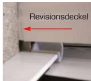
max. Putzkante bei Vorsatzrolläden
