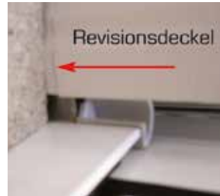
max. Putzkante bei Vorsatzrollläden
